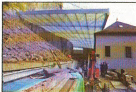
Sur la structure, 170 tonnes de pierres... HOFMANN
