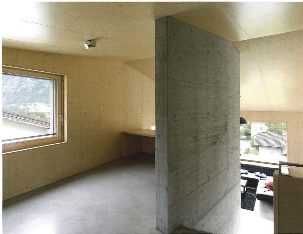
A l'intérieur, des lames de béton verticales encadrent l'escalier qui dessert les étages.
