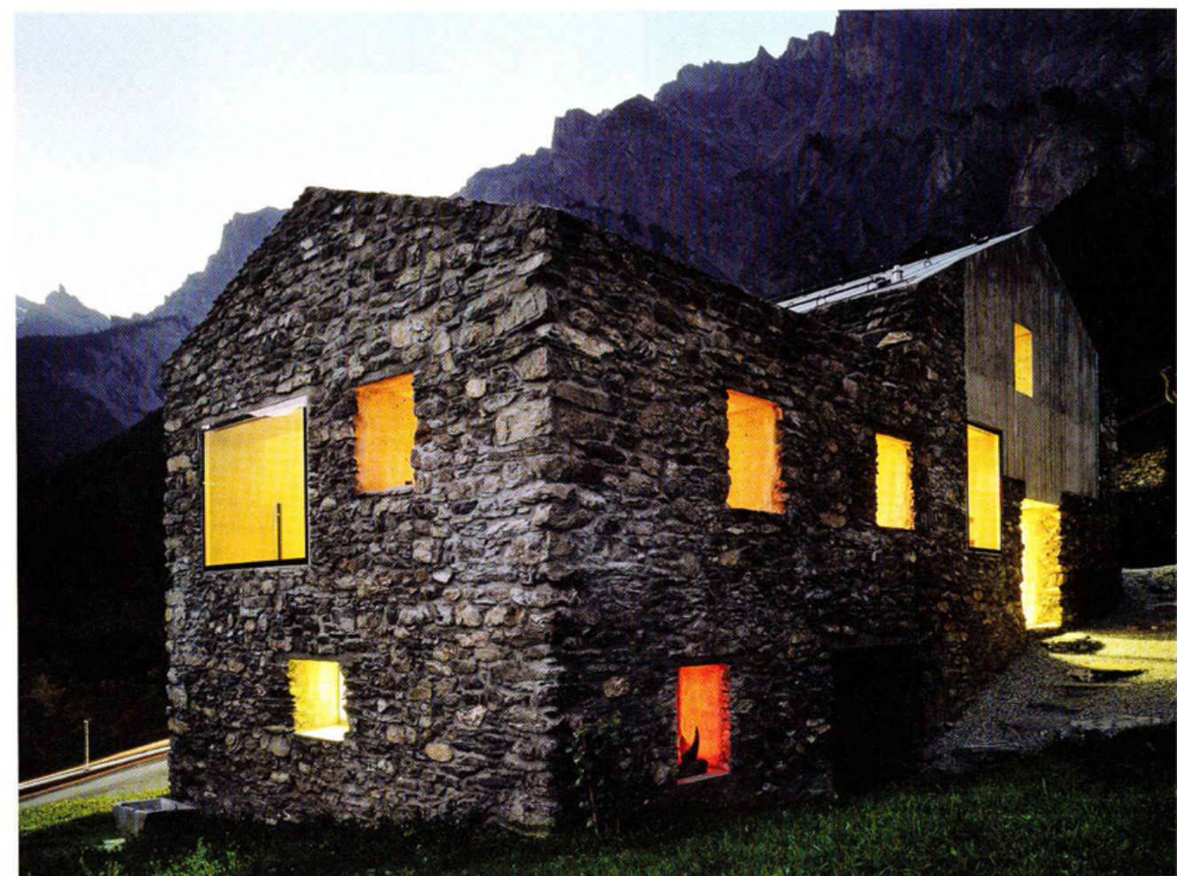
Die Fenster sind mal außen, mal innen bündig eingesetzt und wirken ohne Raster und mit uneinheitlichen Größen wie die zufällig angeordneten Öffnungen einer Höhle
