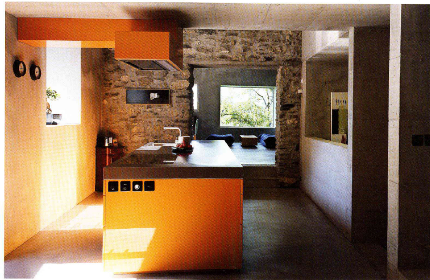
Die Bestandswände bleiben erkennbar aus Naturstein, die ehemaligen Holzkonstruktionen wurden jedoch mit grob geschaltem Sichtbeton ausgetauscht
