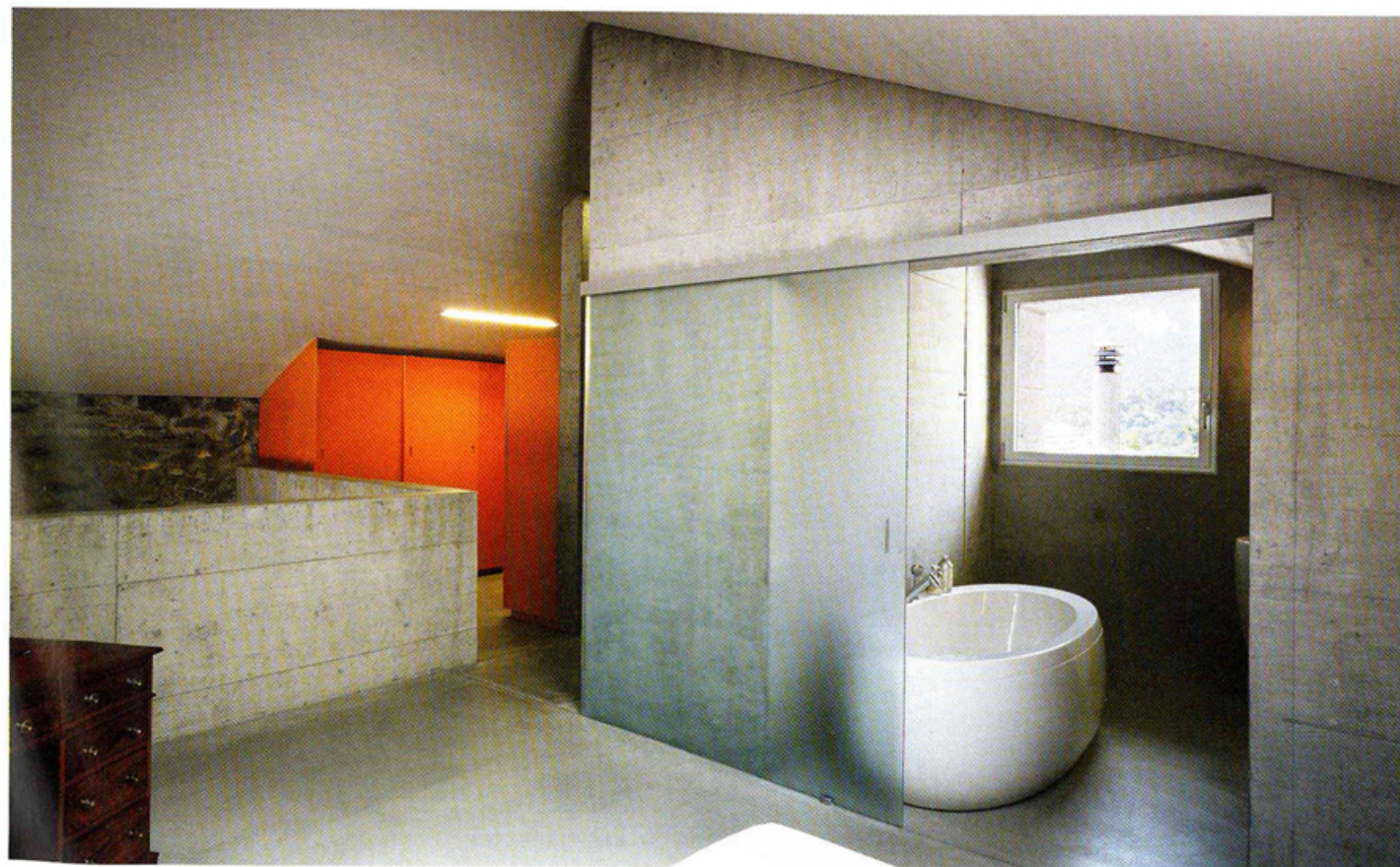
Die Bestandswände bleiben erkennbar aus Naturstein, die ehemaligen Holzkonstruktionen wurden jedoch mit grob geschaltem Sichtbeton ausgetauscht
